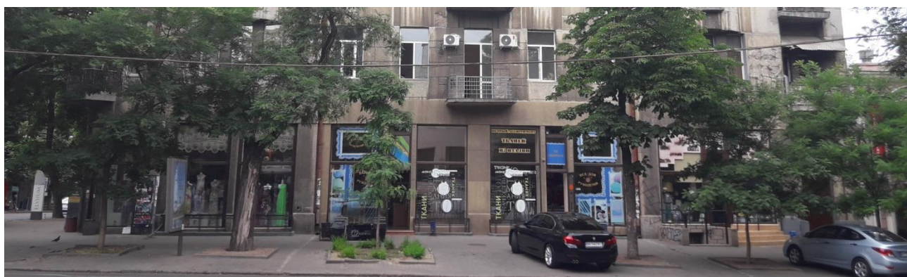
Рис.5.1 Фрагмент фасада первого этажа здания Доходного дома С. В. Шестоपालа, Л. М. Чернигова и Ф. Л. Паппе, Одесса
