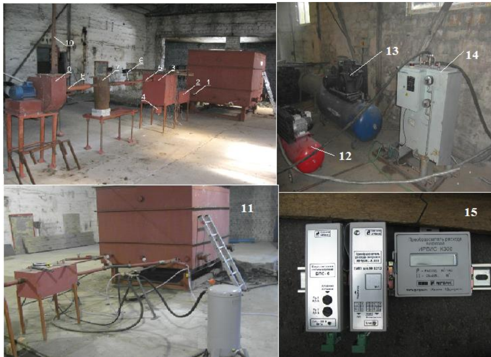
Рисунок 1– Стенд СПГВ (загальний вигляд)
