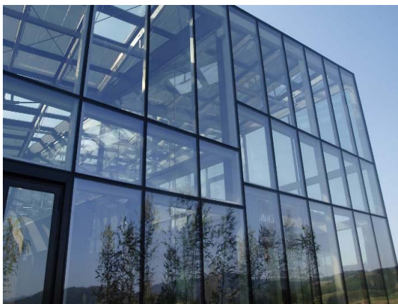
Рис. 1. Будівля з вітражем-стіною стійко-ригельної конструкції
