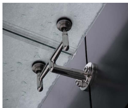
Рис. 4. Шарнірне закріплення кута
