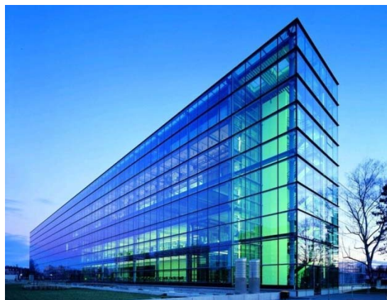
Рис. 2. Будівля із модульно-структурним склінням
