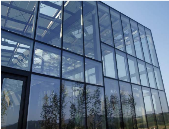
Рис. 1. Будівля з вітражем-стіною стійко-ригельної конструкції
