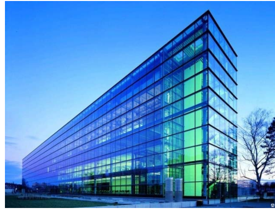
Рис. 2. Будівля із модульно-структурним склінням
