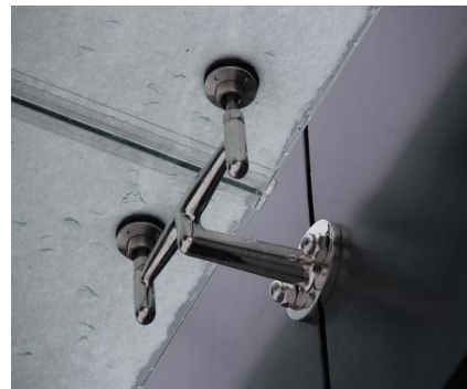
Рис. 4. Шарнірне закріплення кута
